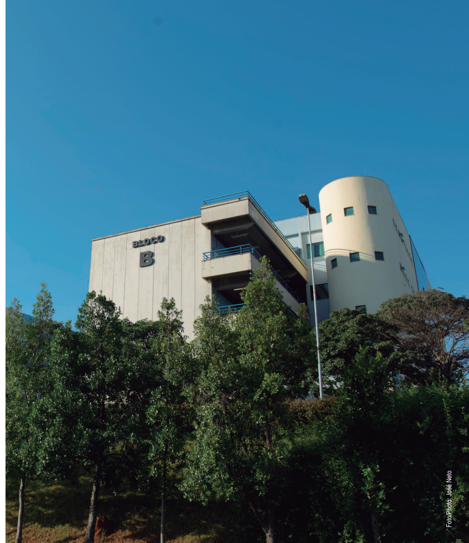
Bloco B, visto a partir do estacionamento da Cidade Universitária The B Building, as seen from the parking lot
