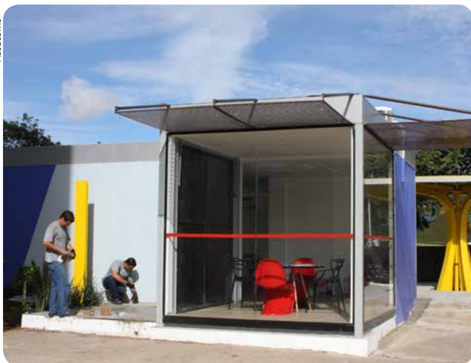
Obras no laboratório estão na reta final, para a inauguração do dia 19
