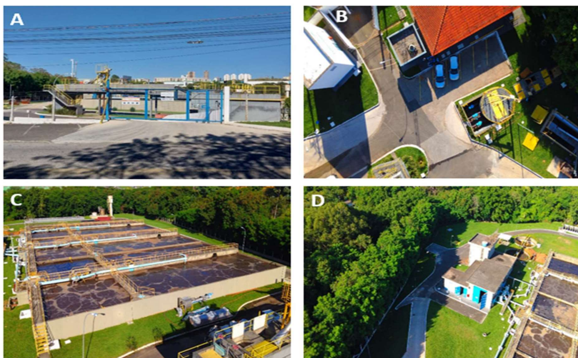
Figura 4 - Vista superior das etapas de tratamento de esgoto sendo, A entrada da ETE Salto do Guimarães; B vista superior da etapa de tratamento preliminar da unidade; C vista superior dos reatores e D vista superior da unidade
