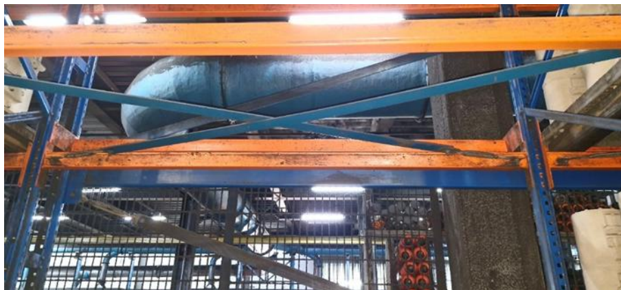
Figura 54 – Contraventamento horizontal
