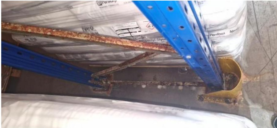
Figura 30 – Componentes oxidados
