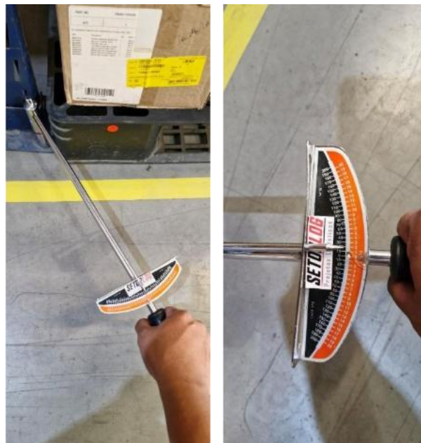
Figura 24 – Verificação do torque dos chumbadores
