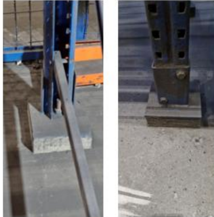
Figura 51 – Chumbadores das estruturas
