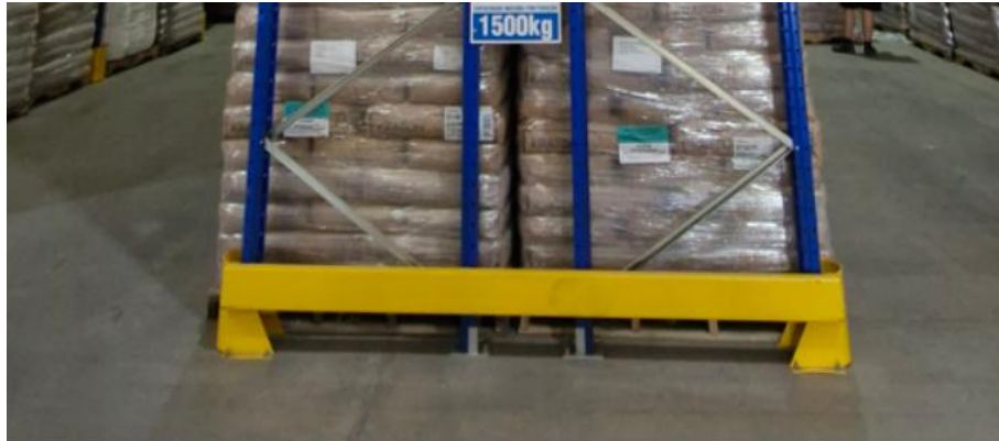
Figura 27 – Protetores de colunas de extremidade
