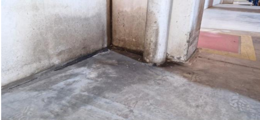
Figura 19 – Junta de dilatação pilar alinhado com Rua 04
