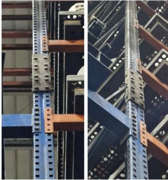
Figura 61 – Junções das colunas
