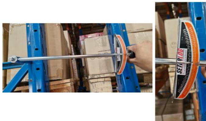
Figura 26 – Verificação do torque dos elementos de fixação
