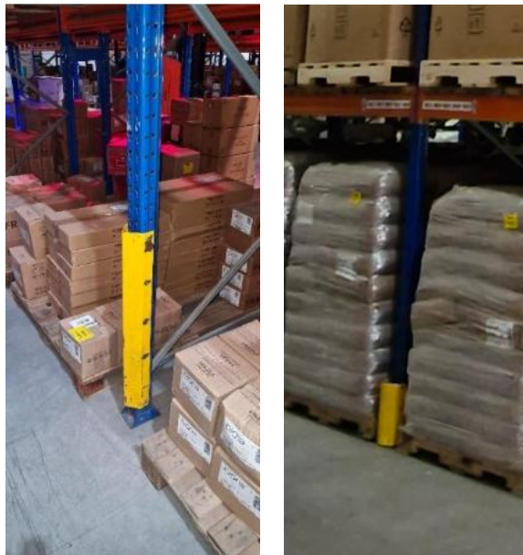
Figura 28 – Protetores de Colunas
