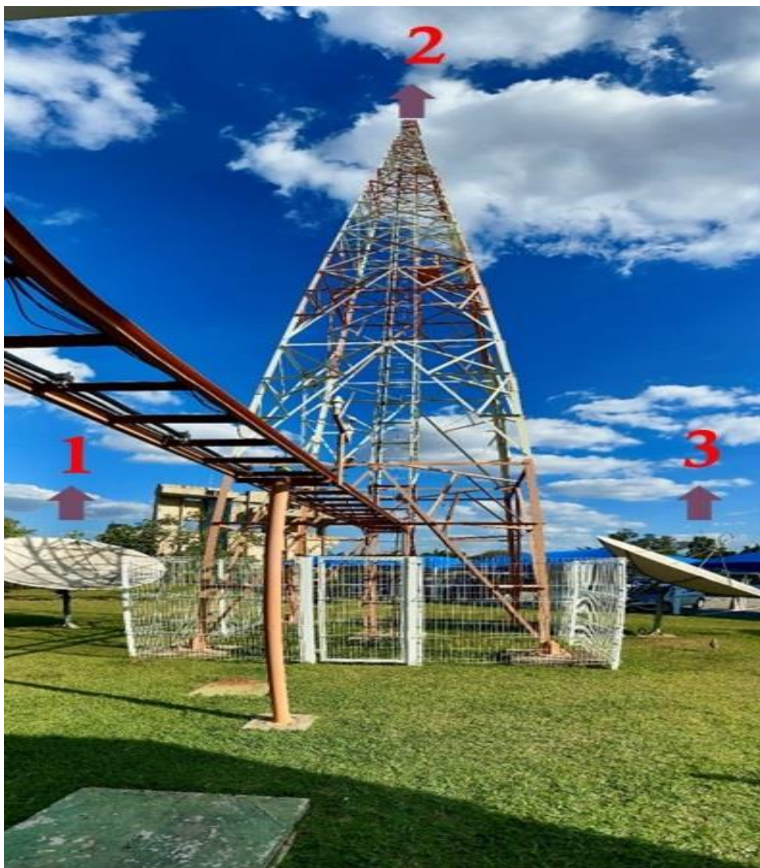
Figura 2 – Torre de Transmissão e Antenas de Recepção de Sinais da Câmara de Sorocaba
