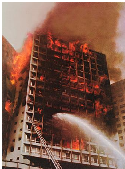
Figura 79: Edifício Joelma em chamas
