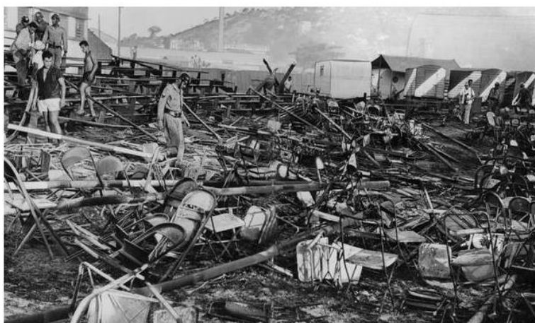
Figura 77: Bombeiros voluntários trabalham nos escombros
