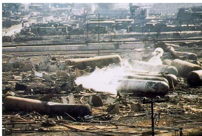
Figura 63: Área de tancagem de vasos de cilindros completamente destruída
