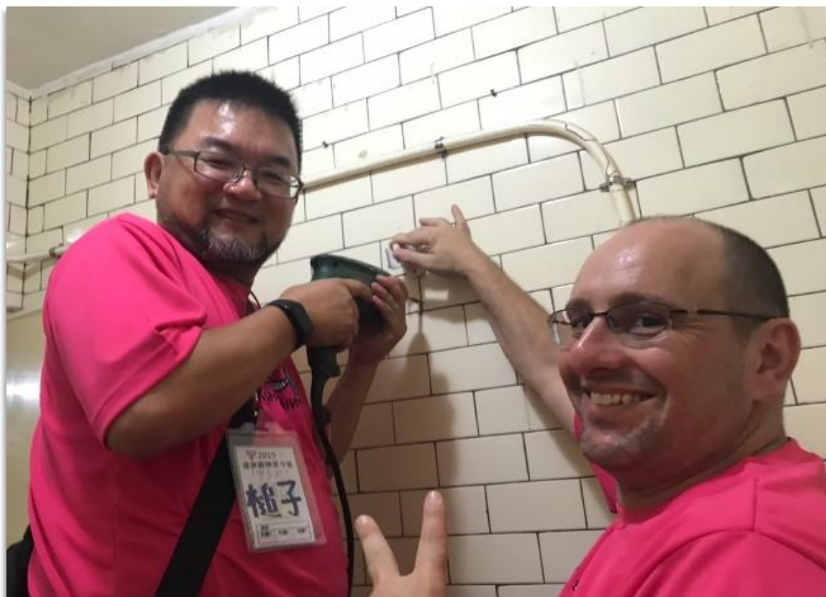
Foto 22 – K.D. e eu na instalação do “novo” chuveiro
