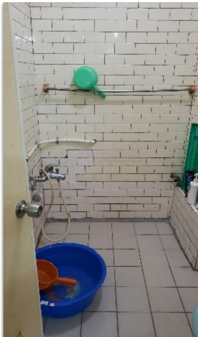
Foto 21 – Banheiro do alojamento
