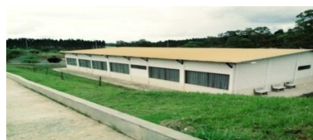
Figura 14: Salas de aula de alvenaria
