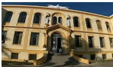
Figura 23: E E Peixoto Gomide – Apresenta verticalidade, janelas retas, clássicas no 1º andar e acima, barrocas com arcos asa de cesto
