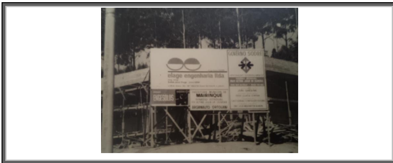
Foto 09 Construção do prédio do Ginásio – 1969 (Fonte: Arquivo Luzia Celeste Chesine Monfrinato)
