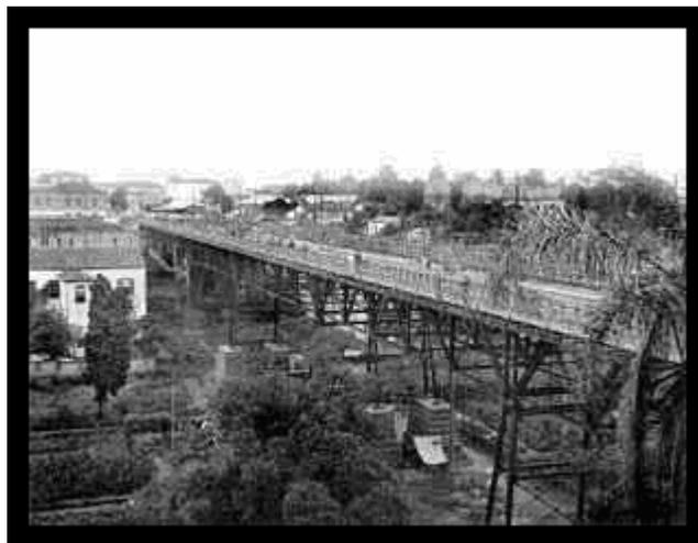
Figura 5. Viaduto do Chá durante as obras de reestruturação de seu leito para trânsito dos bondes elétricos. Foto de 1902, 10 anos antes da construção do G.E.do Carmo. Foto: Marc Ferrez.
