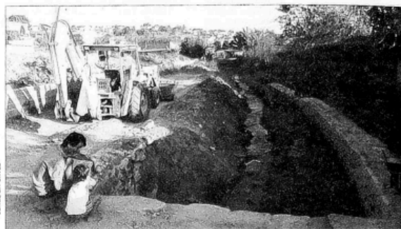
Construção de emissário vai evitar esgoto no córrego do Mineirão
