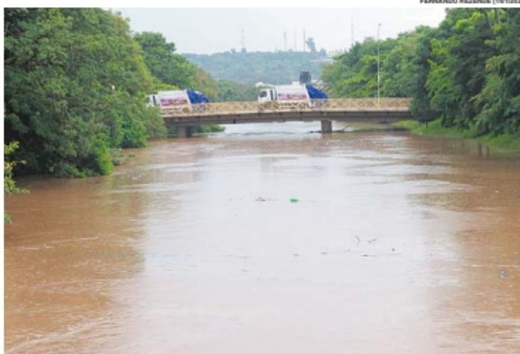
Nível do rio Sorocaba subiu a 1,36 metro. Foram registrados pontos de alagamento na avenida Dom Aguirre
