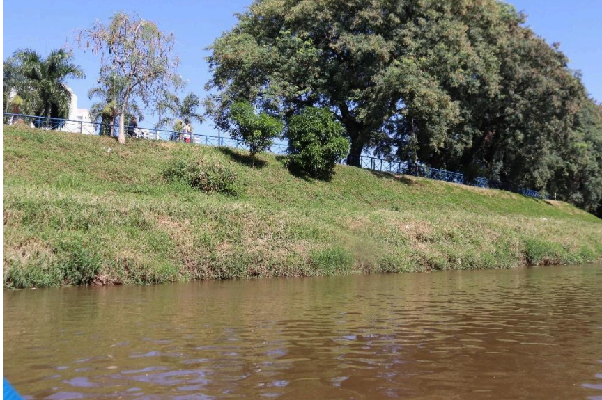
Figura 3 – Fotografia do Rio Sorocaba na Avenida Dom Aguirre em Sorocaba
