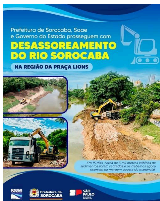
Figura 12 - Publicação sobre as obras de desassoreamento
