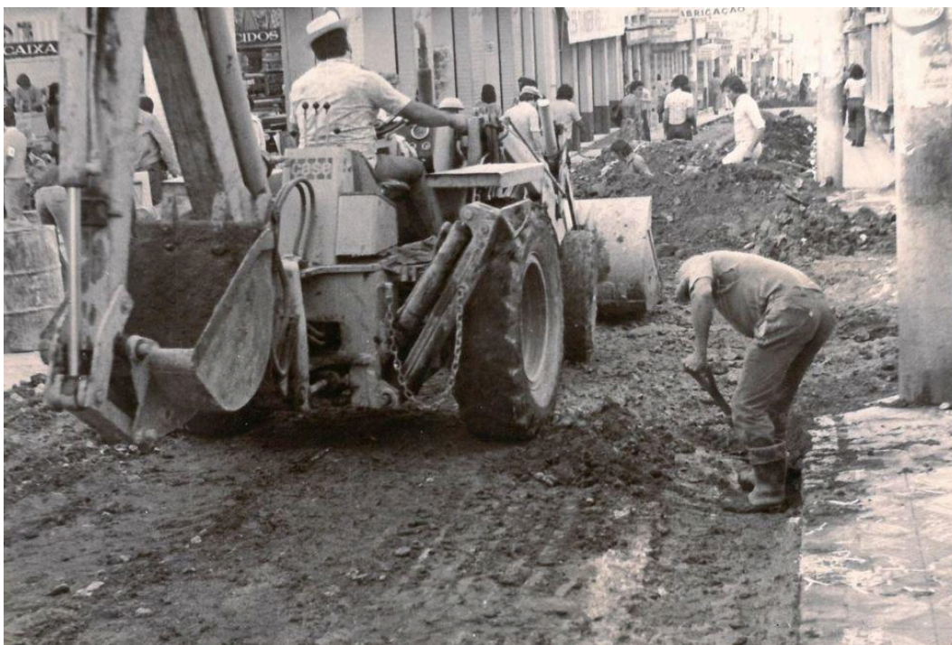
Figura 13 - O boulevard em construção
