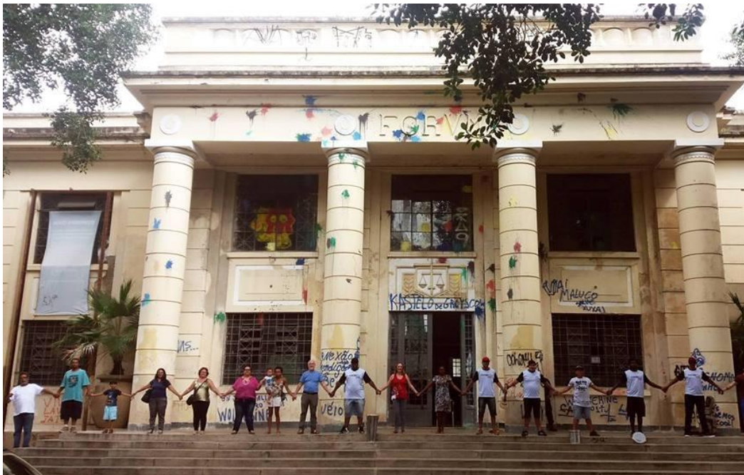
Figura 17 — Prédio da Oficina Grande Otelo em estado de abandono, 2018
