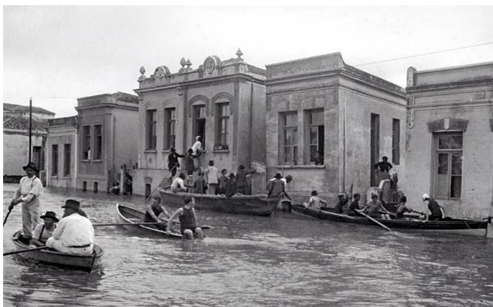
Figura 28 - Foto de enchente rua Iguatemi 1929
