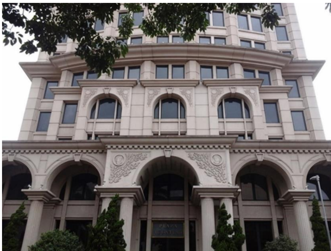
Figura 76 – Fachada do edifício corporativo Iguatemi Plaza
