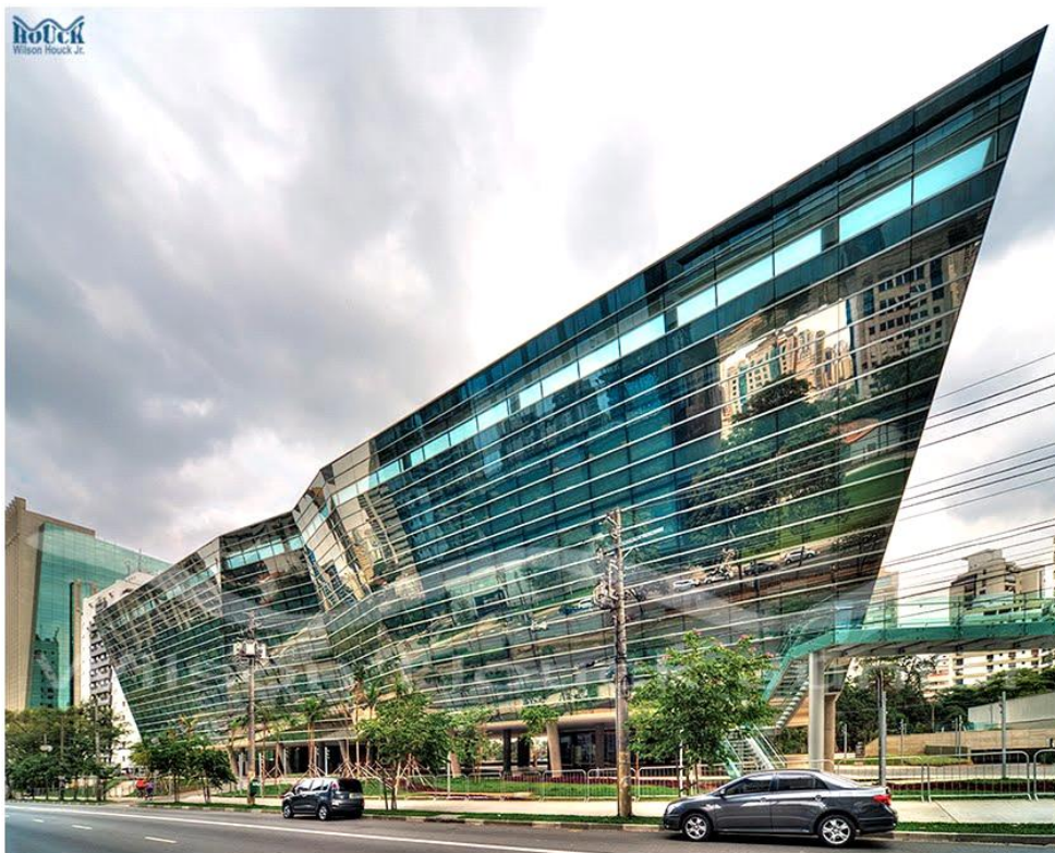
Figura 54 – Edifício Faria Lima 3500
