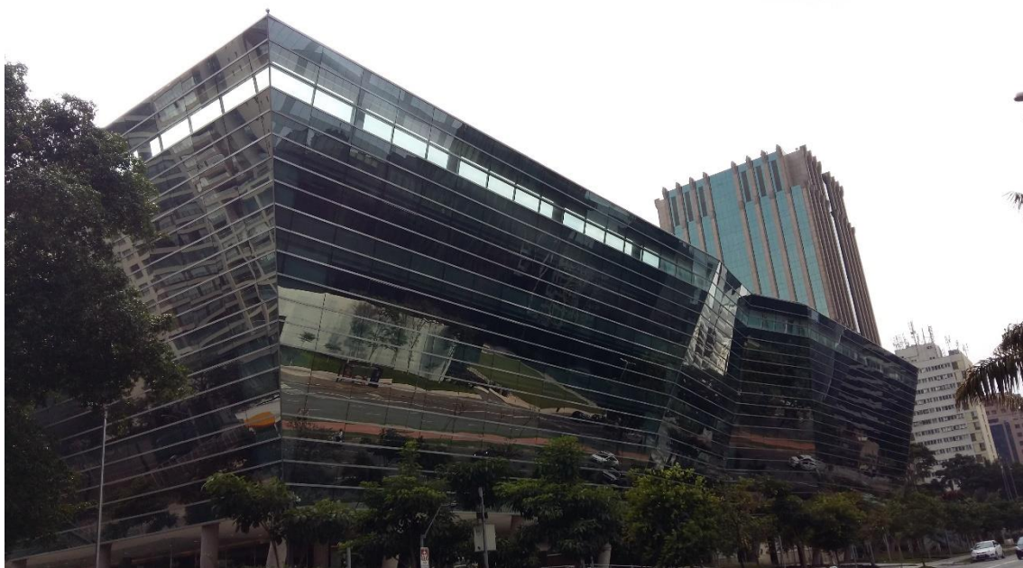
Figura 94 – Edifício Faria Lima 3500
