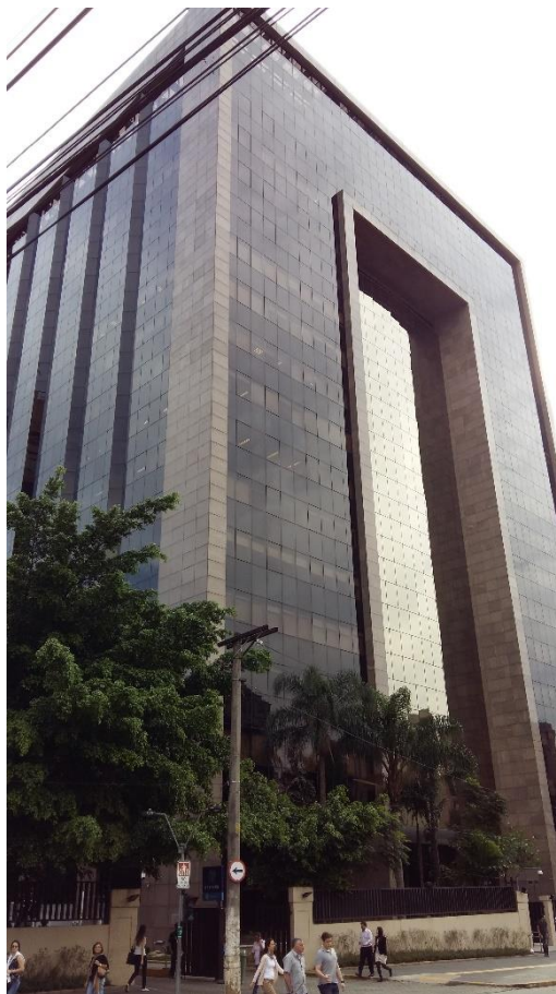
Figura 42 – HSBC Tower – também chamado de L’Arche.
