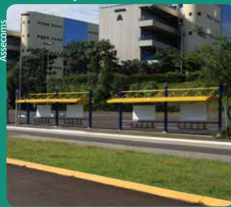
Novos abrigos instalados no câmpus
